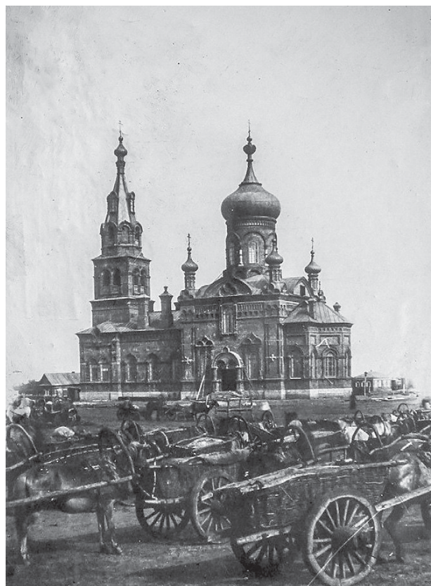
Фото 2. Вид храма после снятия строительных лесов
