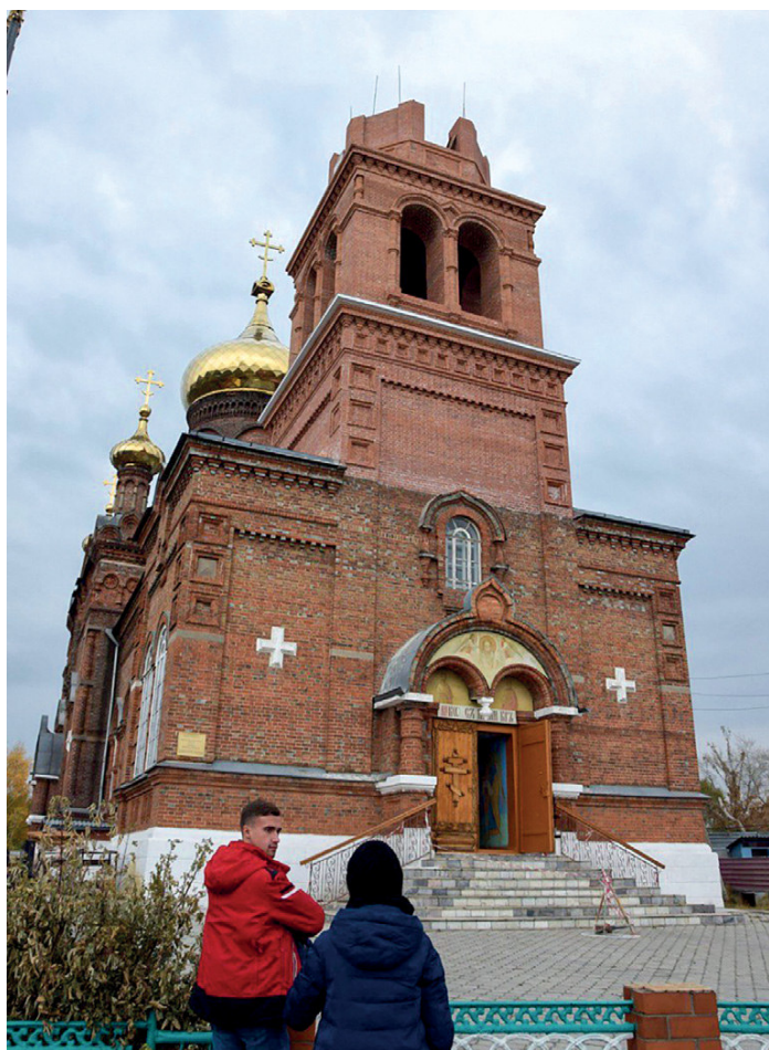
Фото 8. Реставрация храма, работы по восстановлению колокольни
